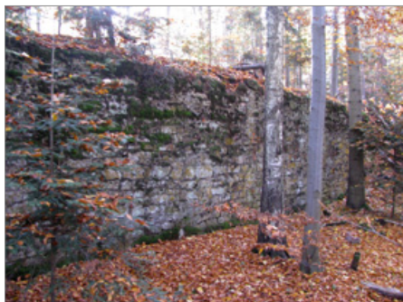
Mur oporowy rampy na terenie kopalni „Ludwik”, fot. Bartosz Kozak
