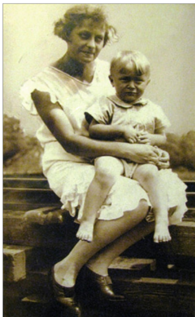
Alina Kubala z synem Mieczysławem na estakadzie kolejki przy obecnej ul. Bodzentyńskiej. Widoczny podkład stalowy dla toru szerokości 600 mm i 750 mm. Suchedniów, 2. poł. lat 20. XX w., zb. Mieczysława Kubali
