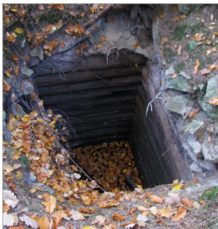
Szyb na terenie kopalni „Ludwik” z zachowaną drewnianą obudową, fot. Bartosz Kozak
