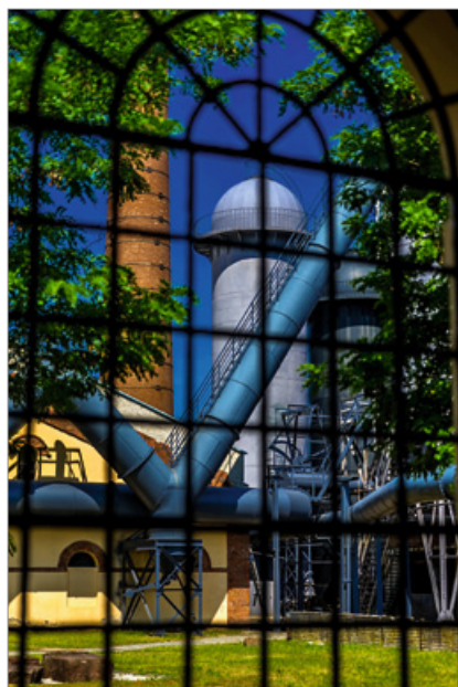
Fragment budynku kotłowni, systemu rurociągów oraz Nagrzewnica Cowpera „Kraków”. Widok z wnętrza budynku Maszyny Wiatrowej, fot. Michał Jabłoński
