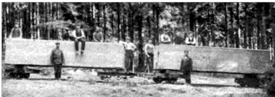
Transport kolejką wyprodukowanych przez firmę A. Wędrychowskiego piaskowcowych wanien służących do wytrawiania stalowych rur.
