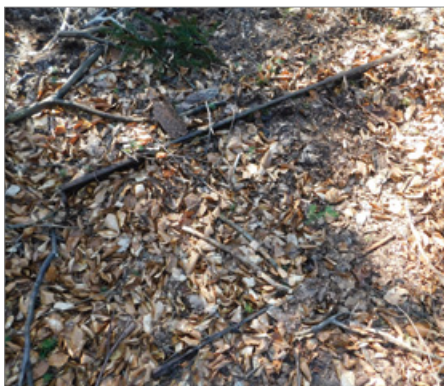
Przerdzewiałe resztki przęśła torowego 75 mm systemu Dolberga- Jałowickiego w rejonie zakończenia linii Suchedniów-Osieczno, fot. Bartosz Kozak
