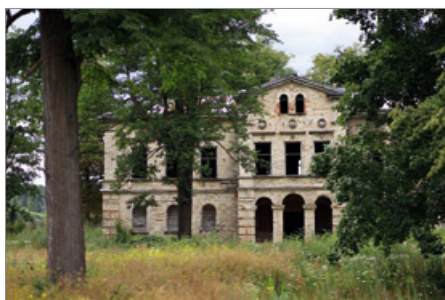
Pałac Schoenberga, widok od strony frontowej budynku. Obecny stan zachowania
