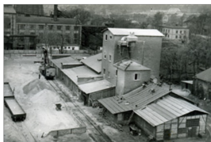
Budynek Hali Lejniczej zamieniony na cegielnię, lata 60. XX w., fot. Mieczysław Kowalski
