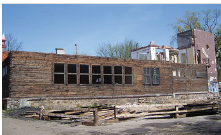
J.w. w trakcie rozbiórki, 2010, fot. K. Myśliński
