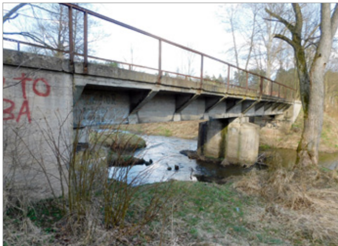
Most kolejki z lat 50. XX w. nad Kamionką. Fot. autor, 2022 r.
