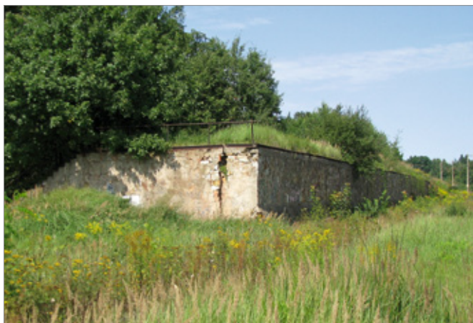
Rampa przeładunkowa kolejki w Suchedniowie. Fot. autor, 2011 r.
