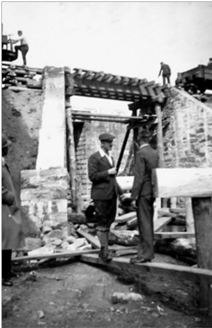
Budowa wiaduktu i estakad w Wierzbce, 1942 r. Ze zb. Władysława Sieradzkiego; ZAML, WS, sygn. 102/75 III V-3
