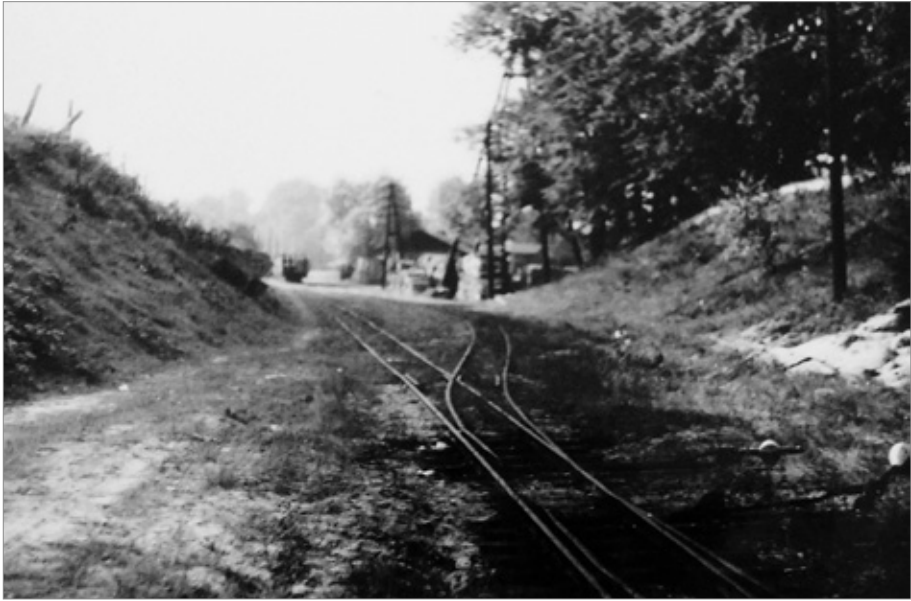
Mijanka na początkowym odcinku Kolejki Bliżyńskiej, między nasypem rampy przeładunkowej (z lewej) a cmentarzem (po prawej); stan z 1973 r. Fot. B. Pokropiński
