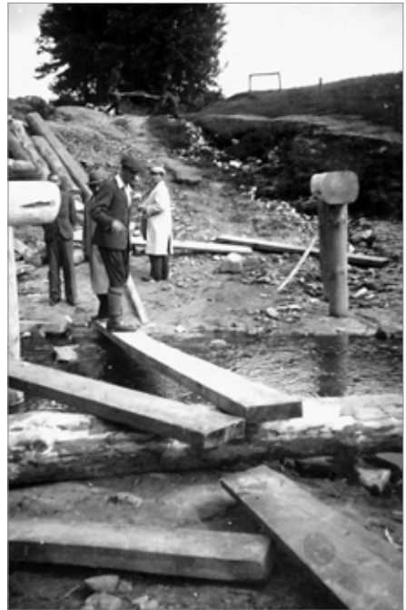
Budowa wiaduktu i estakad. Wierzbka, 1942 r. Ze zb. W. Sieradzkiego; ZAML, WS, sygn. 102/75 III V-3
