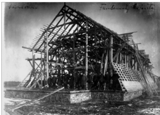
Budowa kościoła pw. Wszystkich Świętych w Starachowicach (jesień 1922 r.). Fot. ze zbiorów Muzeum Przyrody i Techniki w Starachowicach
