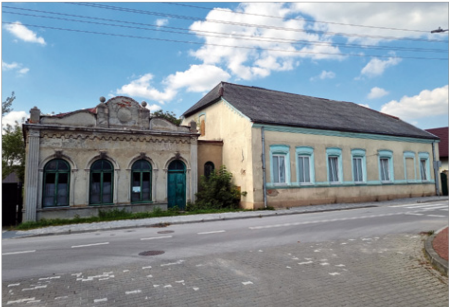
Fot. 11. Budynek bożnicy garbarskiej oraz dom należący niegdyś do Nuty Ajzenberga w Szydłowcu przy ul. Garbarskiej, widok współczesny. Fot. M. Szymkiewicz.
