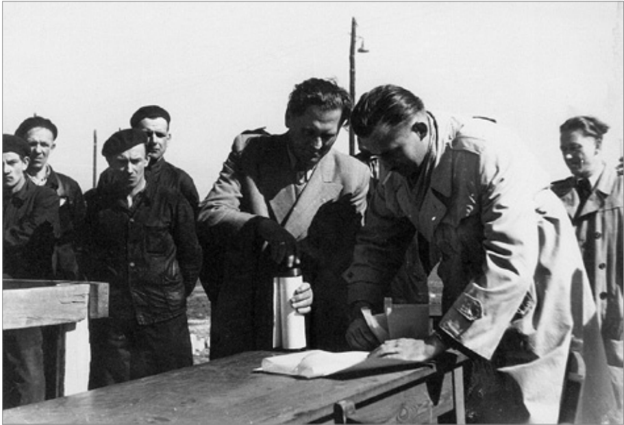
Wmurowanie kamienia węgielnego pod budowę FUT-u
